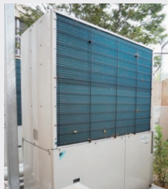
停電時も稼働が可能な電源自立型GHP
