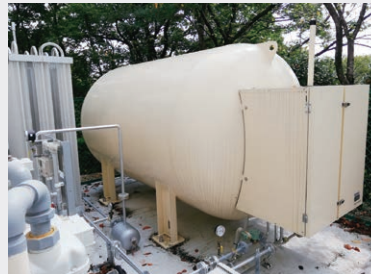
災害バルク貯槽とガス発生装置
